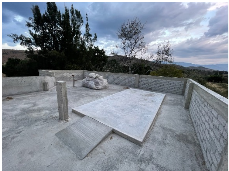
Arriba: PUC 2020-21 financió mejoras de infraestructura para facilitar la transición a una nueva fábrica de harina de mezquite.
